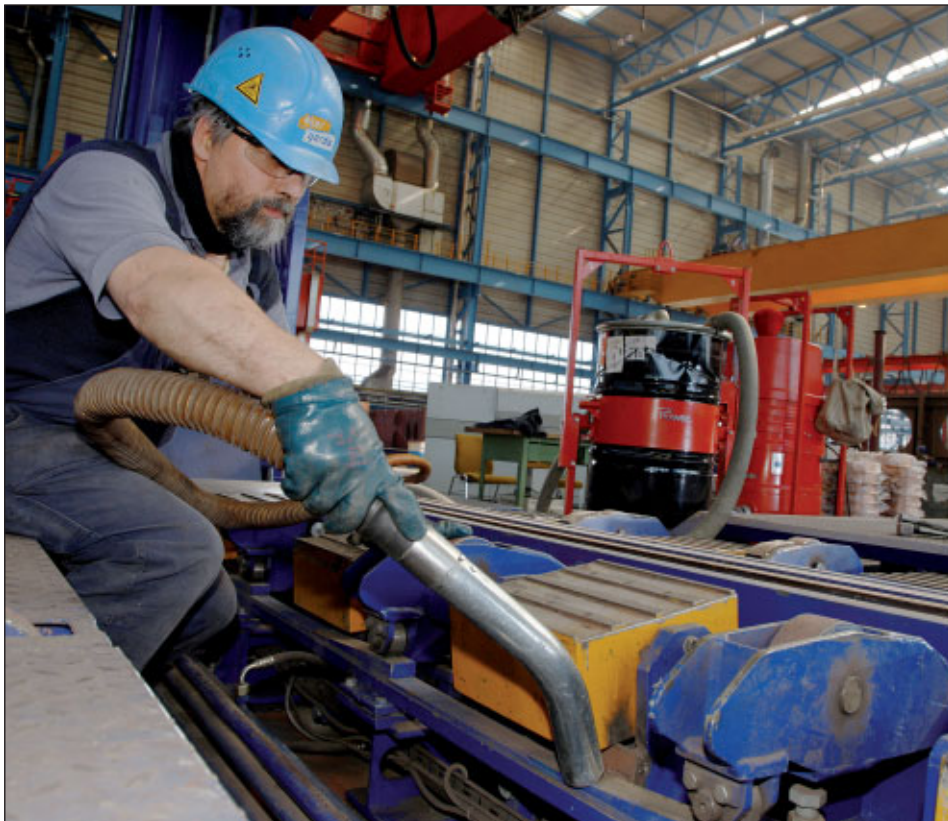
Gesaugt wird hier all das, was beim Schiffbau an Dreck anfällt: Schweißreste, Rost- und Stahlpartikel
