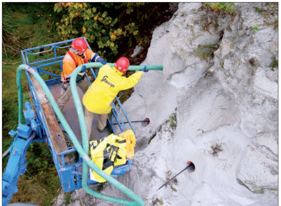
Jedes der 375 Löcher wird vom Bohrstaub befreit
