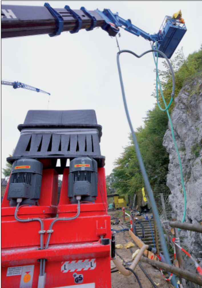
Der DS 4150 saugt aus 375 Bohrlöchern
