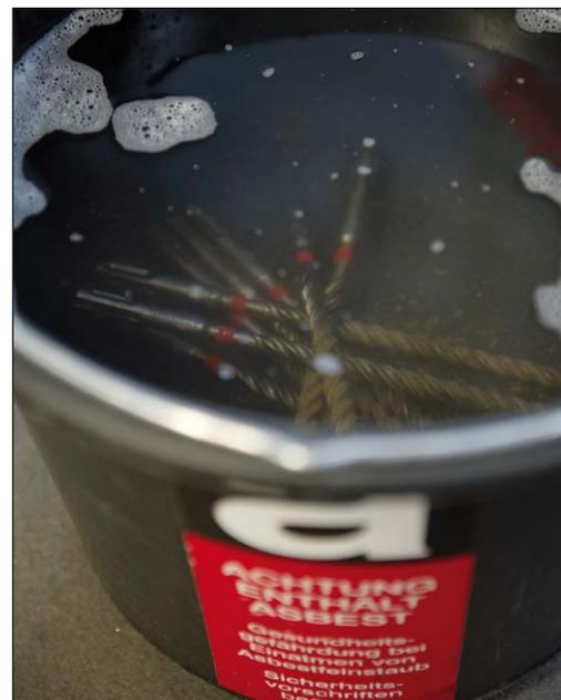
Die Bohrer, die aus dem Asbest-Boden gezogen werden, wandern in eine Lösung mit entspanntem Wasser.
